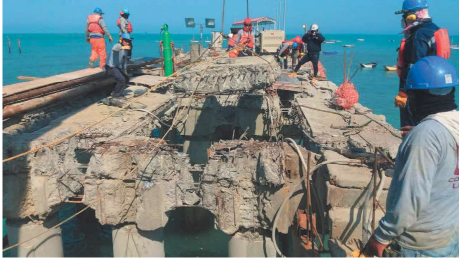
DEMOLICION DE LOSA DE CABEZO Y VIGAS TRANSVERSALES
