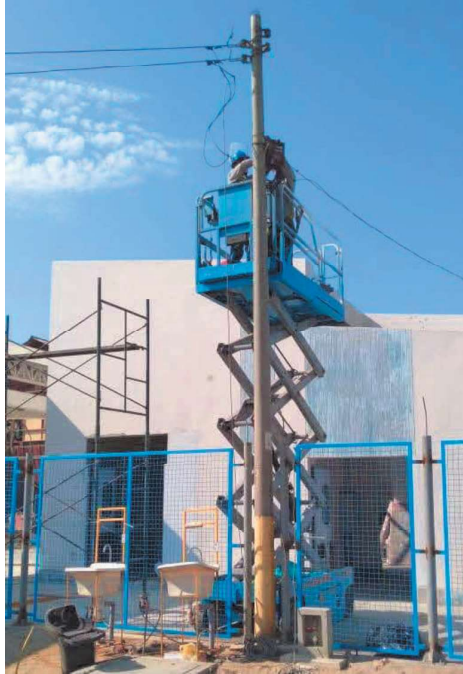
CABLEADO PARA ILUMINACION EXTERIORES
