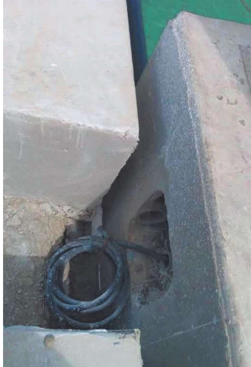
CABLEADO PARA POSTES EN PUENTE 02
