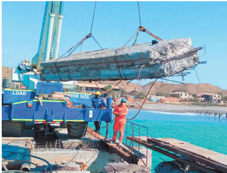
ELIMINACION DE MATERIAL PROCEDENTE DE DEMOLICIONES
