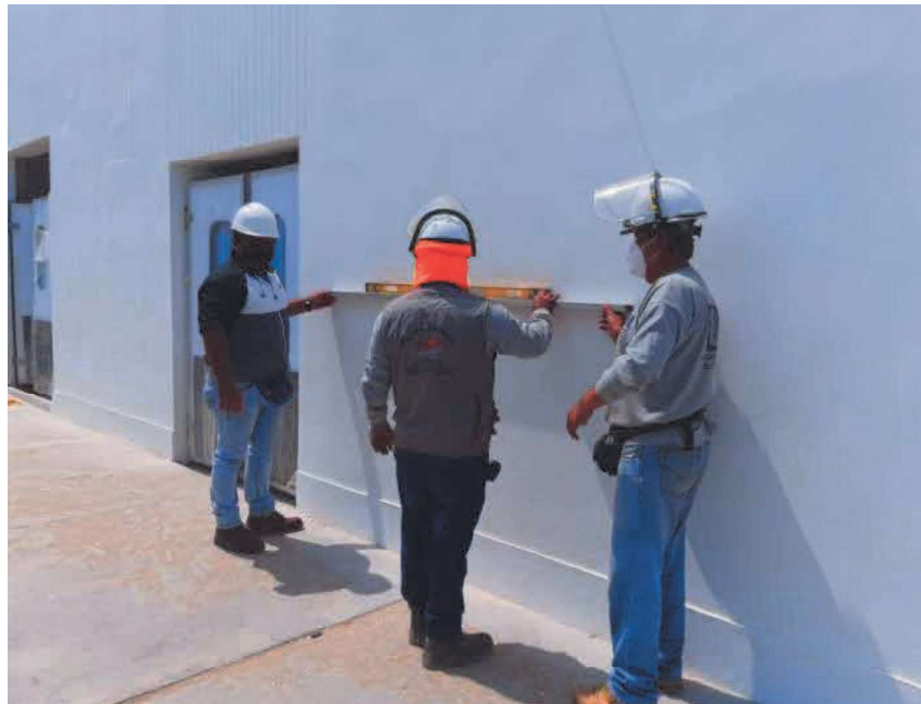
LIBERACION DE TRABAJOS DE PINTURA EPOXICA
