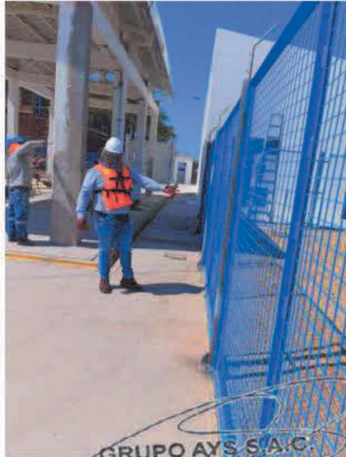
INSPECCION DE LOS TRABAJOS DE CERCO DE MALLA PERIMETRICA EN DPA-LOBITOS
