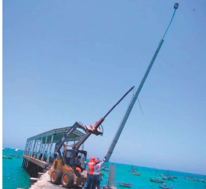
COLOCACION DE POSTES FIBRA DE VIDRIO EN PUENTE 02
