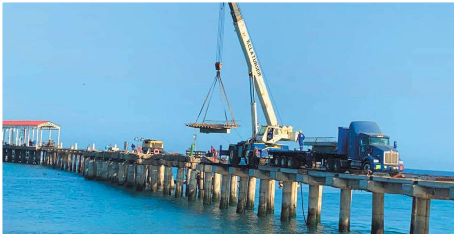
TRANSLADO Y MONTAJE DE LOSAS PREFABRICADAS EN CABEZO
