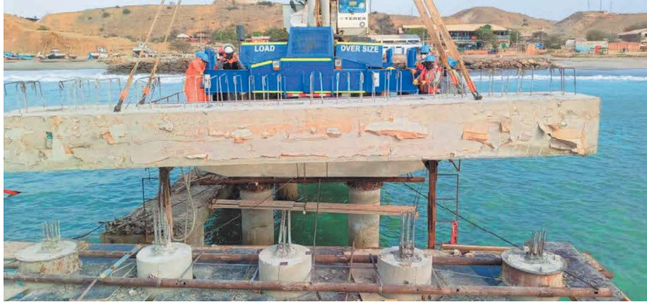
TRANSLADO Y MONTAJE DE VIGAS PREFABRICADAS
