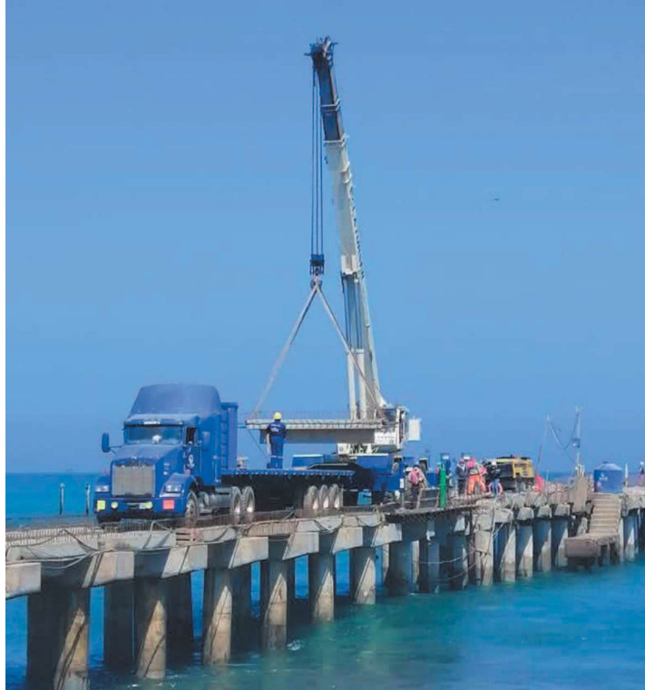
TRANSLADO Y MONTAJE DE LOSAS PREFABRICADAS EN CABEZO
