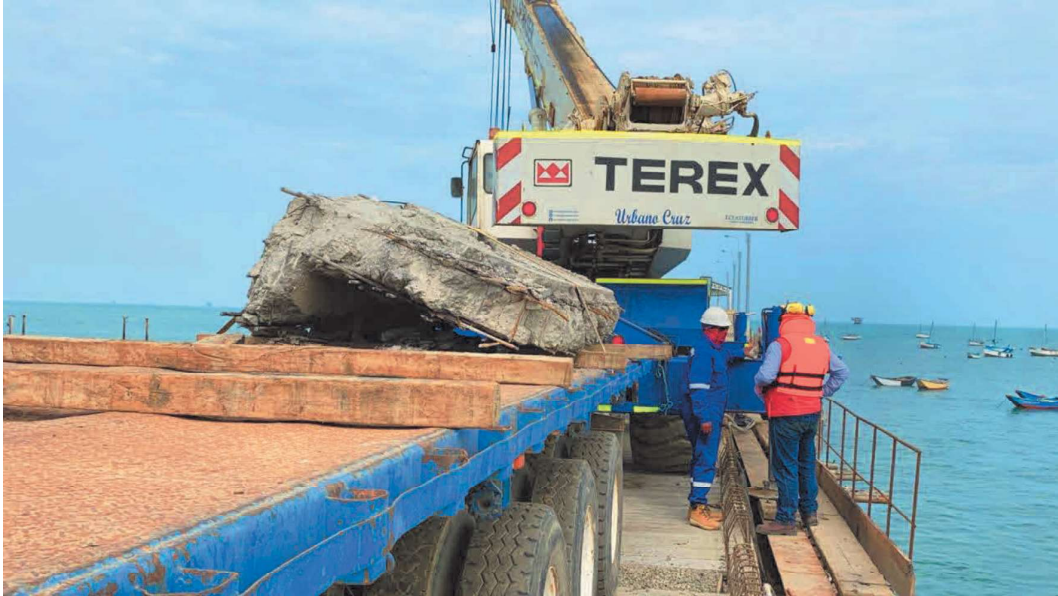
ELIMINACION DE MATERIAL PROCEDENTE DE DEMOLICIONES
