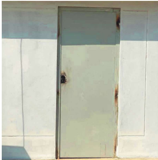
SUMINISTRO E INSTALACION DE PUERTAS METALICA
