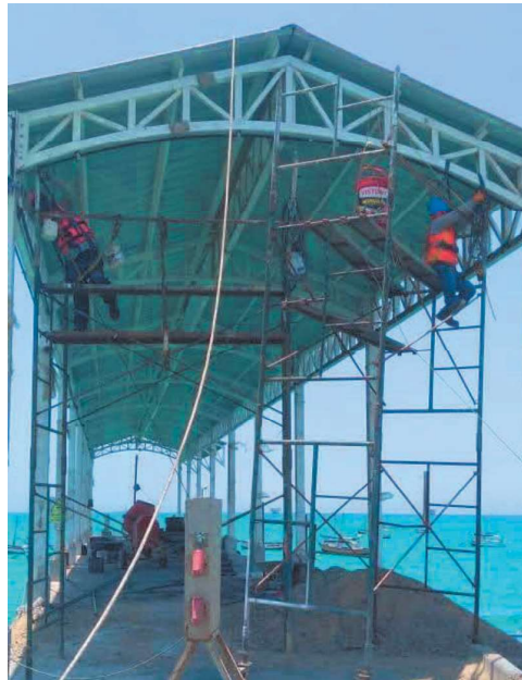
INSTALACION ELECTRICA EN TECHO DE CABEZO 02
