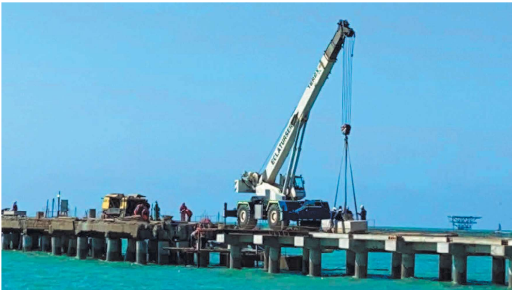
MONTAJE DE LOSAS PRE FABRICADAS
