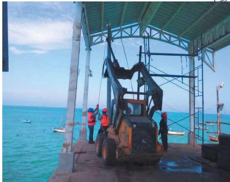
COLACION DE POSTE DE FIBRA DE VIDRIO PARA BALIZAJE E ILUMINACION
