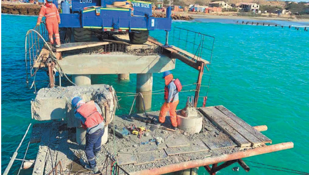
DEMOLICION DE VIGA EN MUELLE
