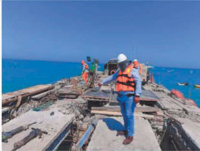
VERIFICACION DE DEMOLICION DE LOSA Y VIGA TRASVERSAL DE CABEZO N°01
