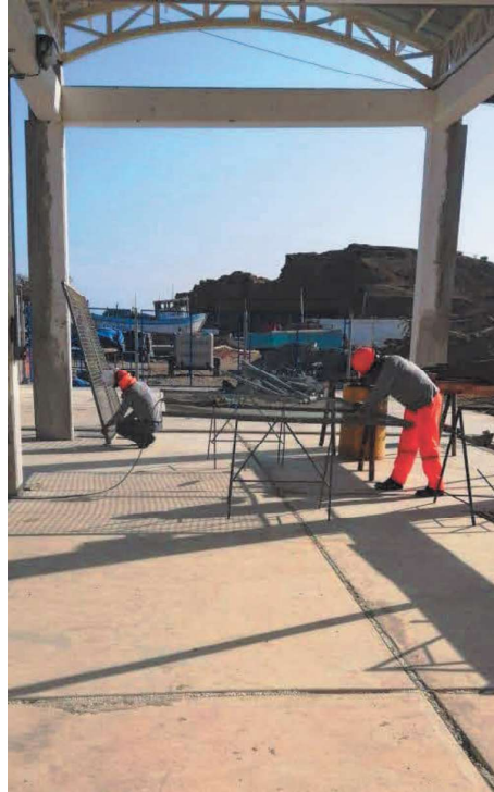
HABILITADO DE ACERO
