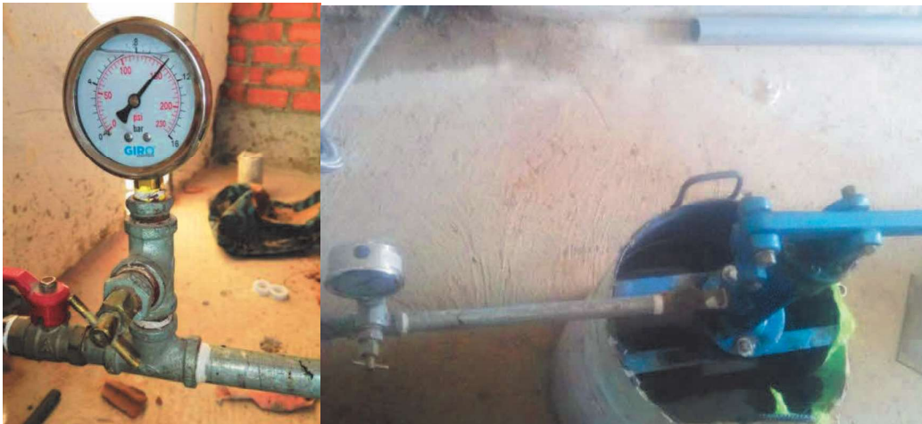
PRUEBA HIDRAULICA EN TUBERIAS DE AGUA
