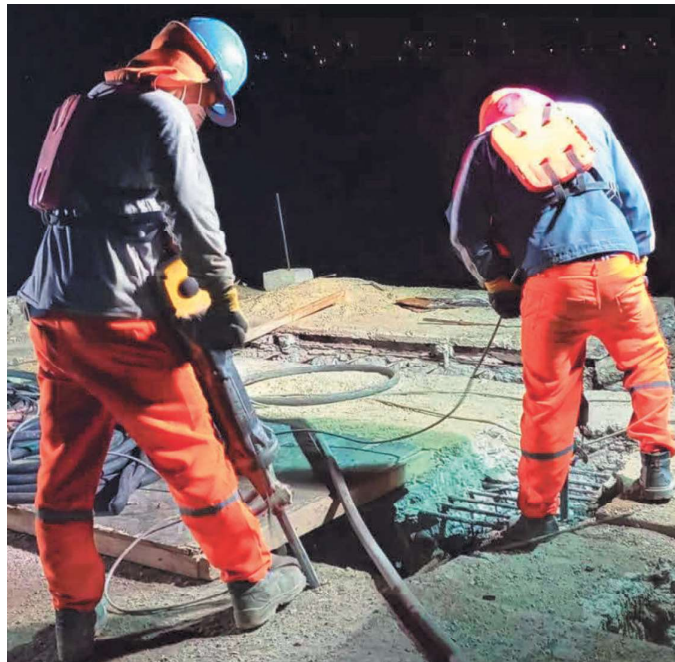
DEMOLICION DE LOSA EN MUELLE
