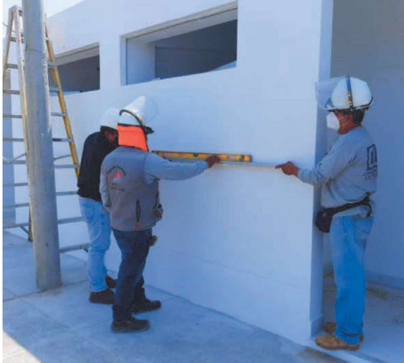
LIBERACION DE TRABAJOS DE PINTURA LATEX/EPOXICA
