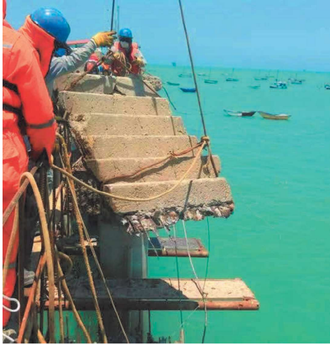
DEMOLICION DE LOSA DE ESCALERA
