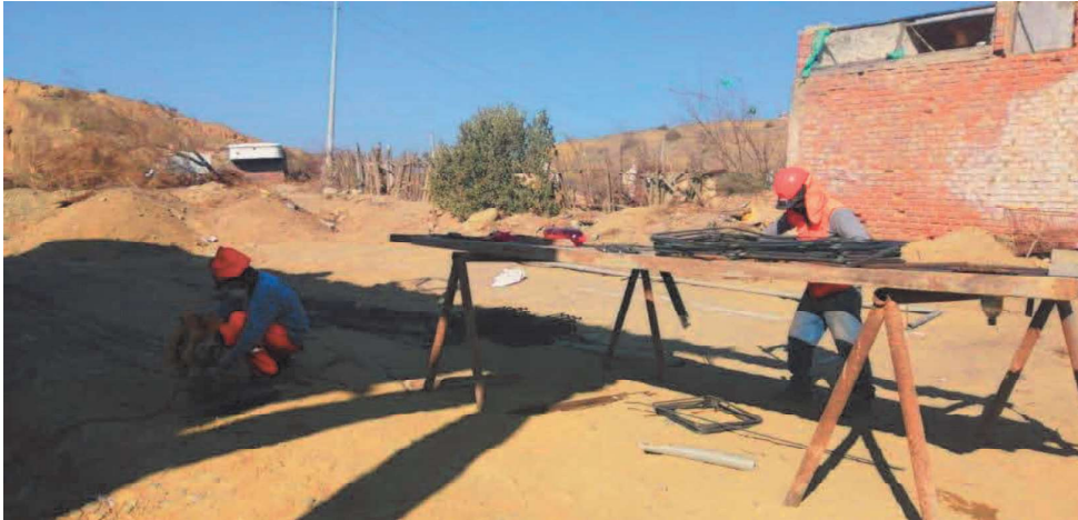
HABILITADO DE ACERO PARA PATIO Y LOSA MACIZA
