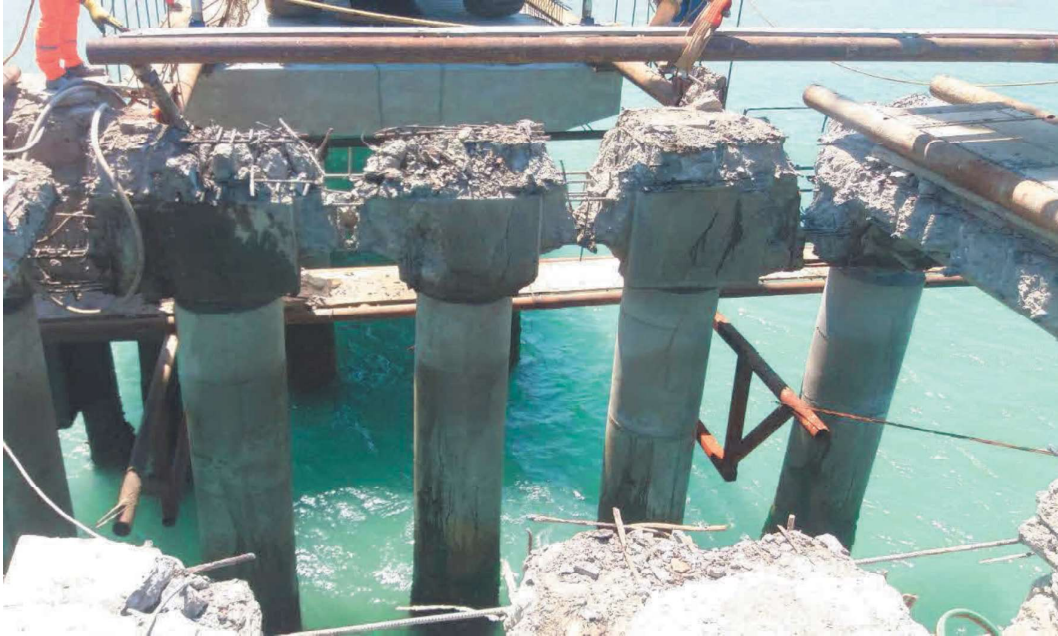
DEMOLICION DE LOSA DE CABEZO Y VIGAS TRANSVERSALES DE CONCRETO ARMADO
