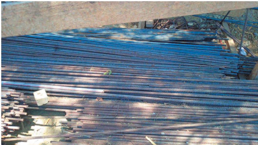
HABILITADO DE ACERO PARA PATIO Y LOSA MACIZA
