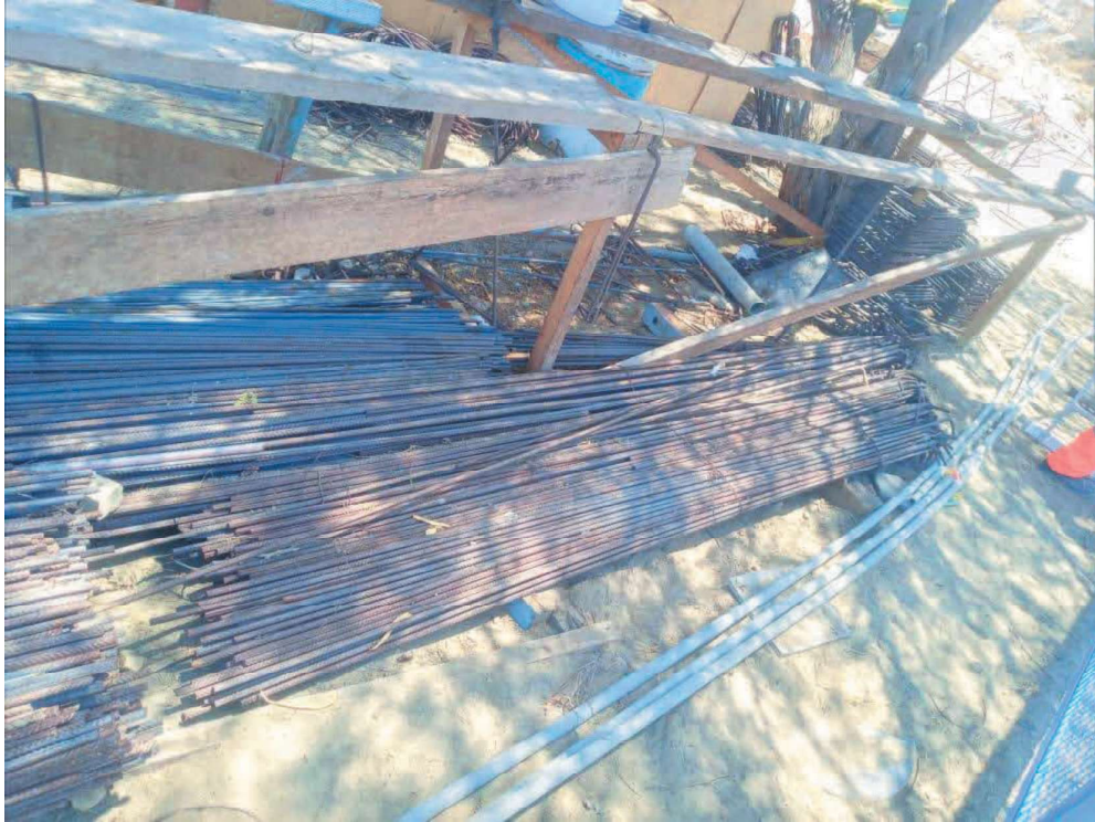
HABILITADO DE ACERO PARA PATIO Y LOSA MACIZA
