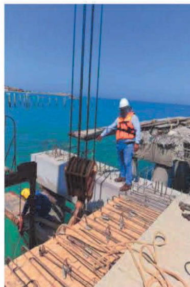
VERIFICACION DE LOS TRABAJOS DE TRASLADO Y MONTAJE DE VIGA PREFABRICACA EN CABEZO
