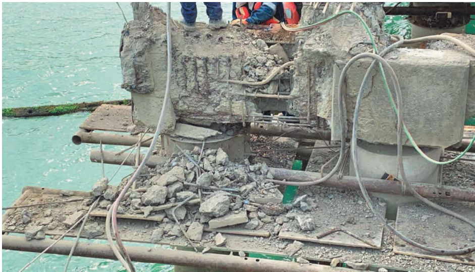
DEMOLICION DE VIGAS TRANSVERSALES DE CONCRETO ARMADO EN CABEZO
